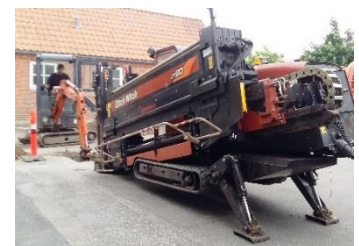
Boremaskinen der er ved at bore sig ind under graverbygning og kapel.
